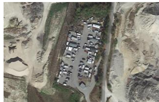
Aire d'accueil de Gex (01), située à l'écart de la ville, entre deux sites de carrières et d'enfouissement de déchet © google maps
